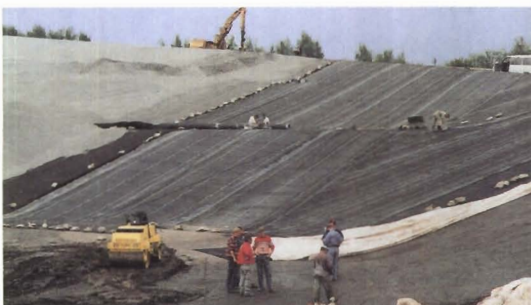
Basisabdichtung, südlicher Deponieausbau, 1994
