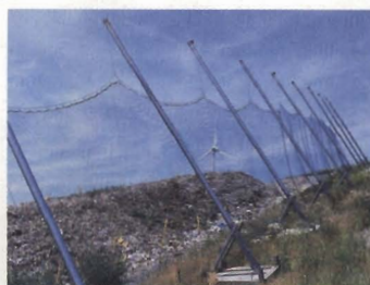
Fangzäune rund um das Deponiegelände
