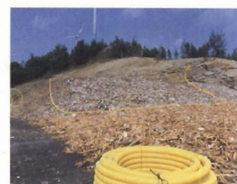
Hausmüll-Rottemiete auf der neu errichteten Rottefläche Nord-Ost, 2001
