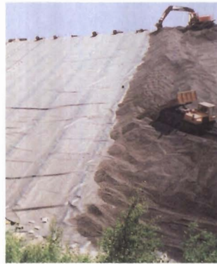
Oberflächenabdichtung für den Deponie-Ostkopf, Deponieabschluss, 1. Phase, 1998/1999
