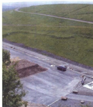
Bereits rekultivierter Deponieabschnitt, 2001
