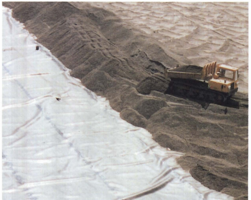
Versiegelung eines verfüllten Deponieabschnitts mit Kunststoff-Dichtungsbahnen
